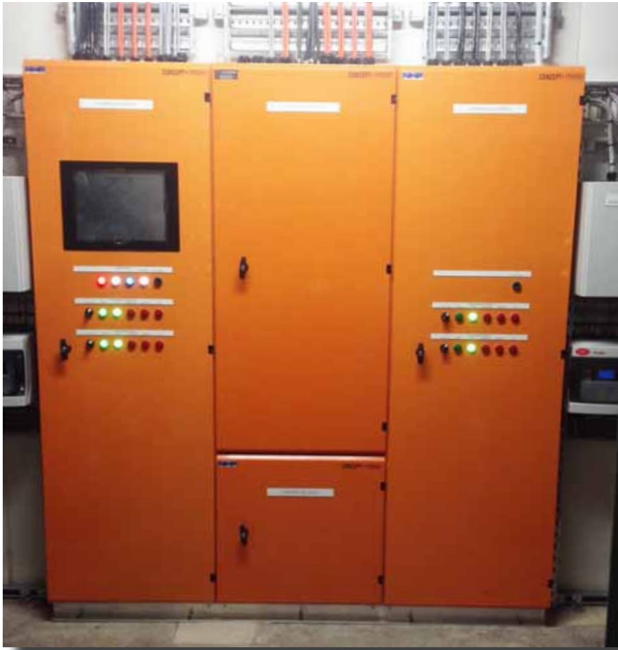
Figura 1: Cada instalação monitora e controla a refrigeração, o consumo de energia, a iluminação e a geração de energia.
